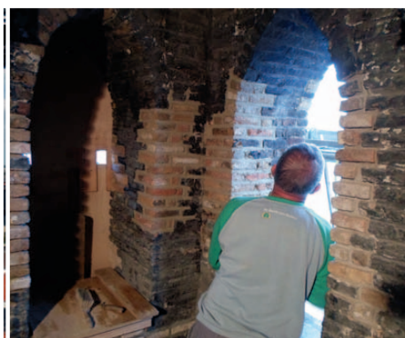
Herstel metsel- en voegwerk van de galmgaten aan de binnenzijde in de torenspits.
