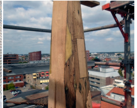
Herstelde koningstijl met aanlopers stijlen.
