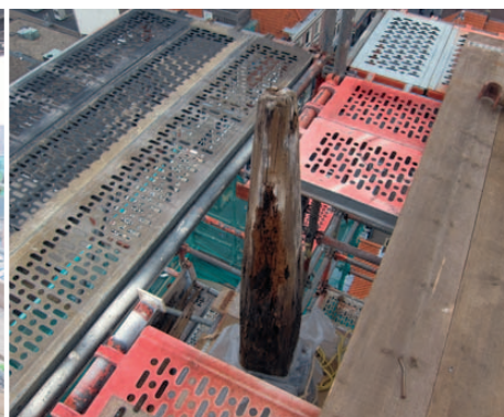
Aangetaste koningstijl.
