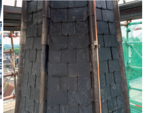
Spits voorzien van leiwerk en bliksebeveiliging.
