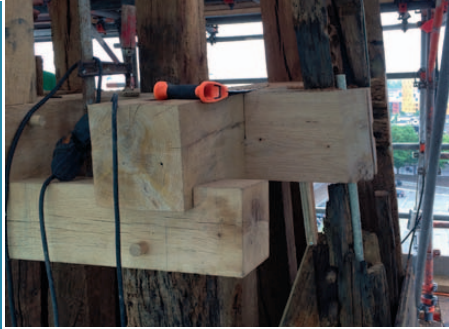
Bruinrotaantasting in de torenspits. Traditioneel herstel in combinatie met moderne technieken om zoveel mogelijk authentiek materiaal te kunnen handhaven.
