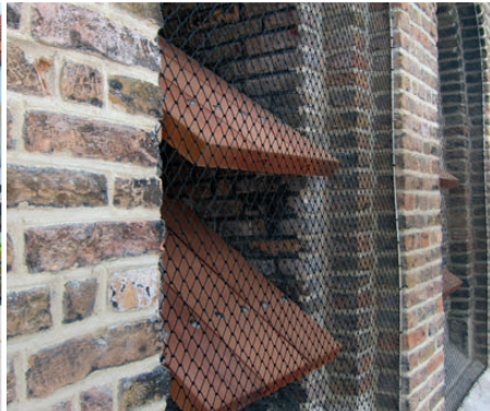
De galmgaten na restauratie en voorzien van duivenwering.
