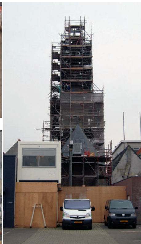
Achterzijde van de kerk met bouwplaats.
