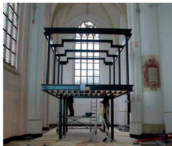
Het frame van een van de nieuwe units wordt geplaatst in november 2014. (foto: Diana Immerzeel)
