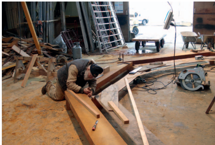
Foto boven: De (geverfde) vijzel wordt aangebracht.
