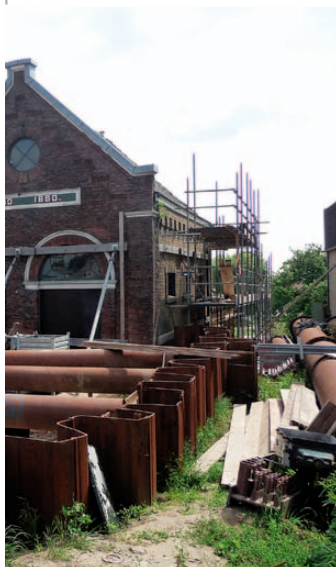
Het pomphuis zonder kap en op één pilaar. De instroom kan zo goed worden vernieuwd / gerestaureerd.
