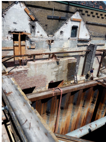
Met de silent piling techniek zijn damwanden geplaatst, zowel bij het pomphuis als rondom de maalkom en bij de uitstroom
