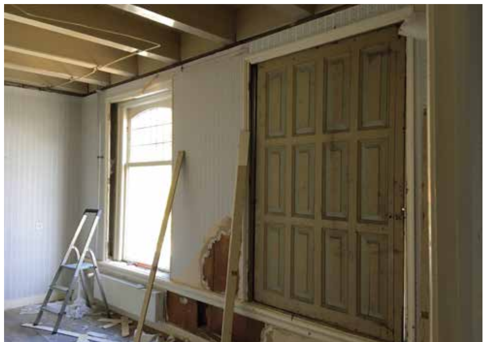
In de opkamer zijn ingenieuze dagblinden teruggevonden, een heel bijzonder interieuronderdeel (een klapsysteem). Ze worden hersteld zodat ze net als eerst overdag weggeborgen kunnen worden en 's avonds de vensters kunnen afdekken.
