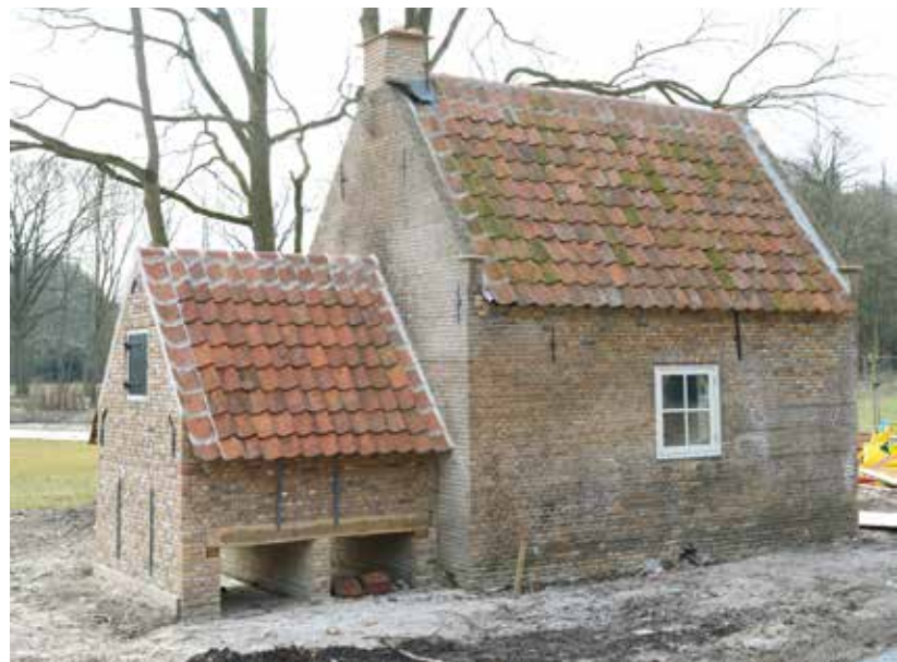
Het bakhuis met onder de houtoven ruimte voor een houtvoorraad.
