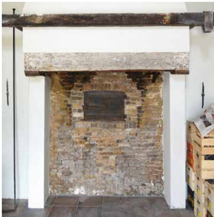
De schouw in het bakhuis. De oven kreeg een kleinere deur, waarvoor het metselwerk rondom is ingeboet.
