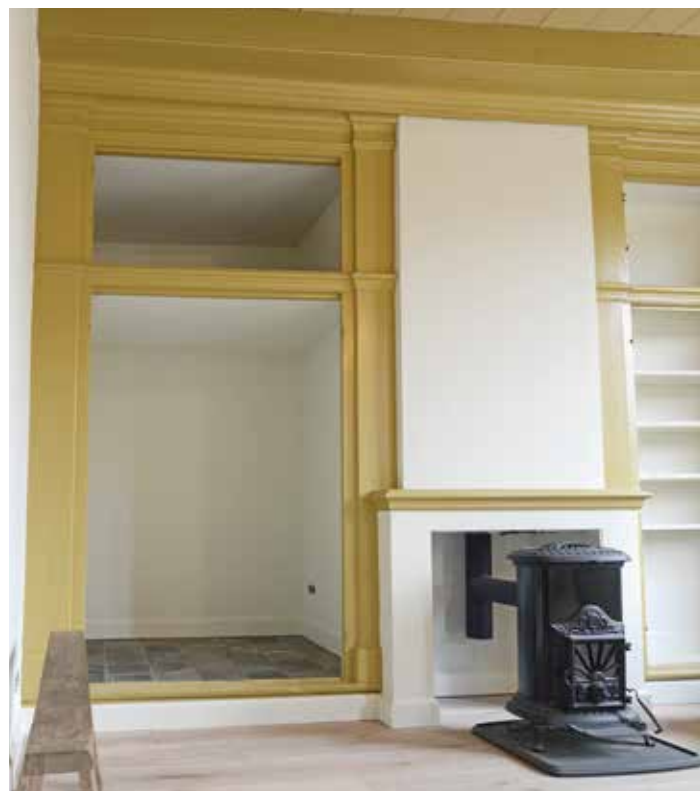
Vondst achter de schrootjes in de herenkamer: fraai lijstwerk rond de haardpartij en een bedstede. De oude scharnietjes voor de bedstededeuren zaten nog in het hout.
