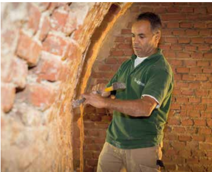
In de middeleeuwse kelder is het stucwerk verwijderd. De kloostermoppen blijven in het zicht.
