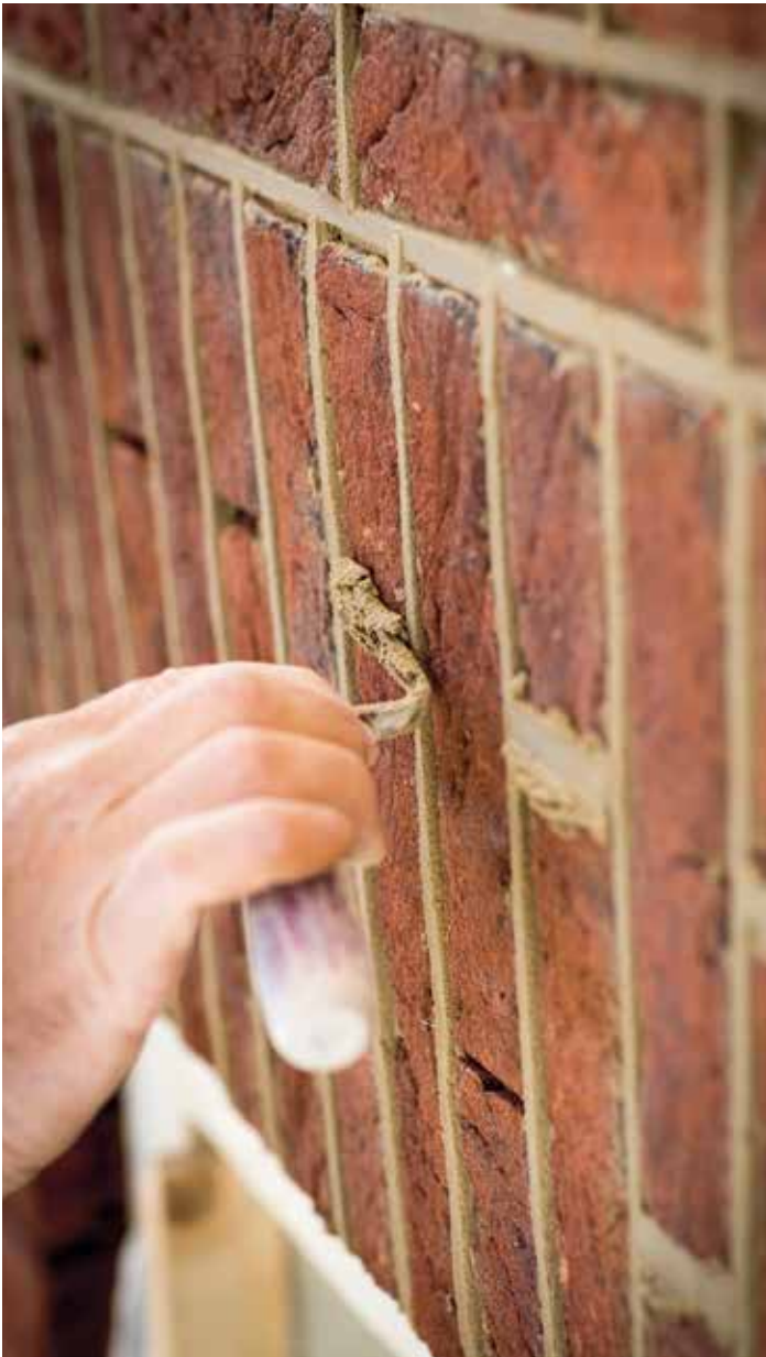
Het voegwerk krijgt een knipvoeg.
